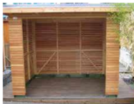
1. abris à containers
