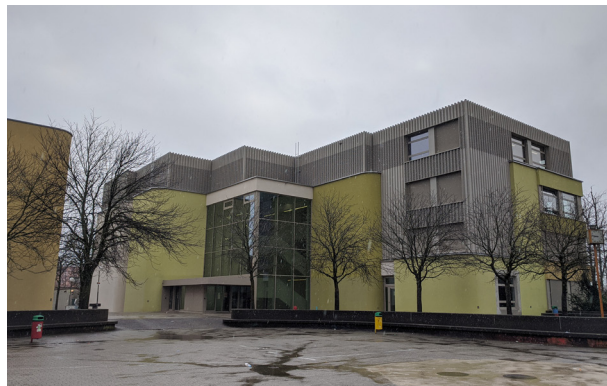
Assainissement et surélévation - Perrereys bloc E
