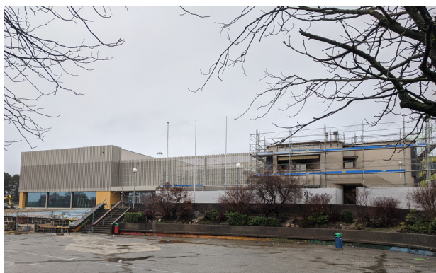
Nouvelle salle de gym - Perrereys bloc D
