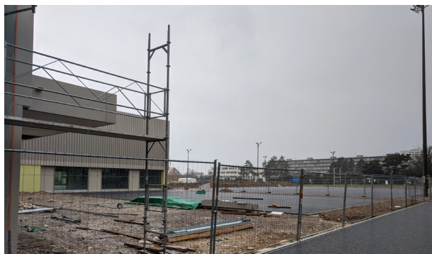
Réfection terrains de sports 1
