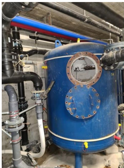
Filtres à sable des Perrerets hors service (à droite : le trou d'homme est ouvert)
