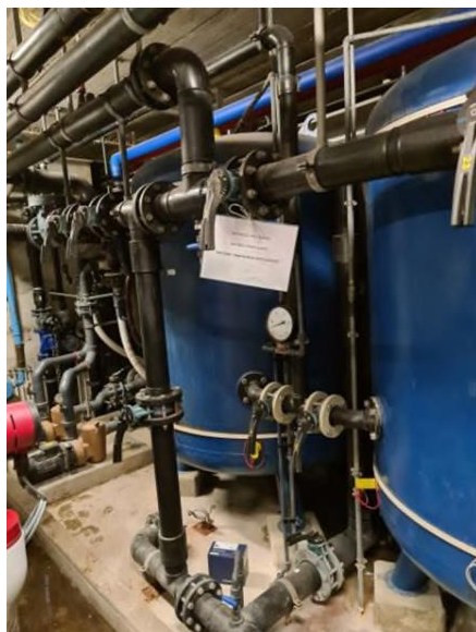
Filtres à sable des Perrerets hors service (à droite : le trou d'homme est ouvert)
