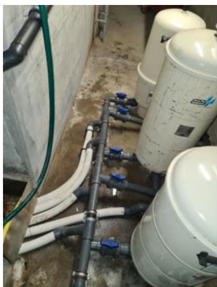
Filtres à diatomées provisoires installés dans la galerie technique devant le bassin tampon (à droite : filtre ouvert, on distingue les plateaux qui seront recouverts par les diatomées)
