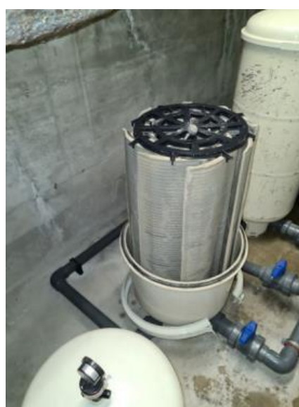
Filtres à diatomées provisoires installés dans la galerie technique devant le bassin tampon (à droite : filtre ouvert, on distingue les plateaux qui seront recouverts par les diatomées)
