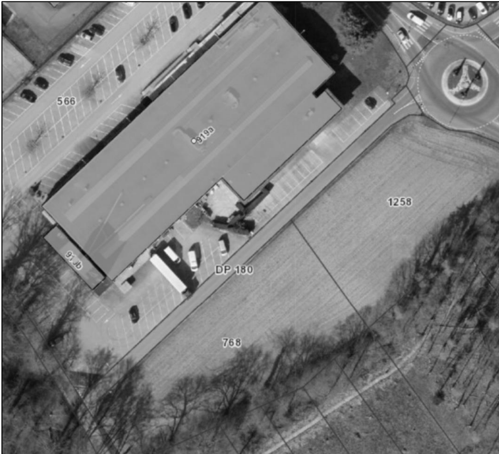
Chemin des Fontenailles (DP180) : absence de trottoir et stationnement perpendiculaire au domaine public
