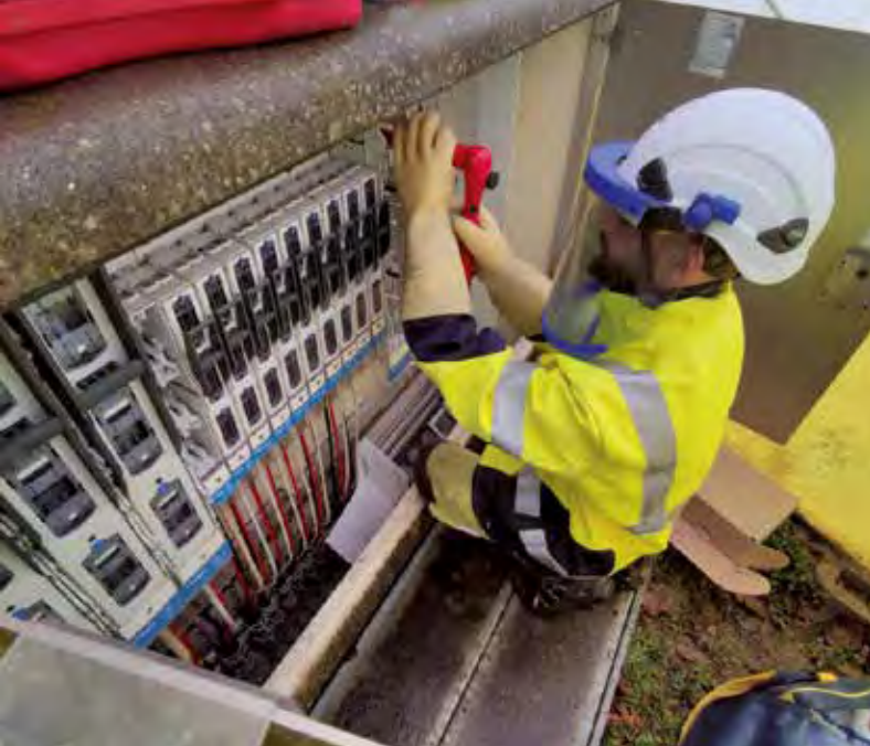
Travail sous tension, sans devoir couper l'alimentation du client
