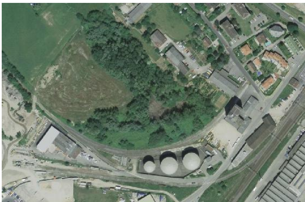
FIGURE 26 : ANCIENNE LOCALISATION DES CITERNES (SOURCE : http://www.geoplanet.vd.ch/pdcn/ )
