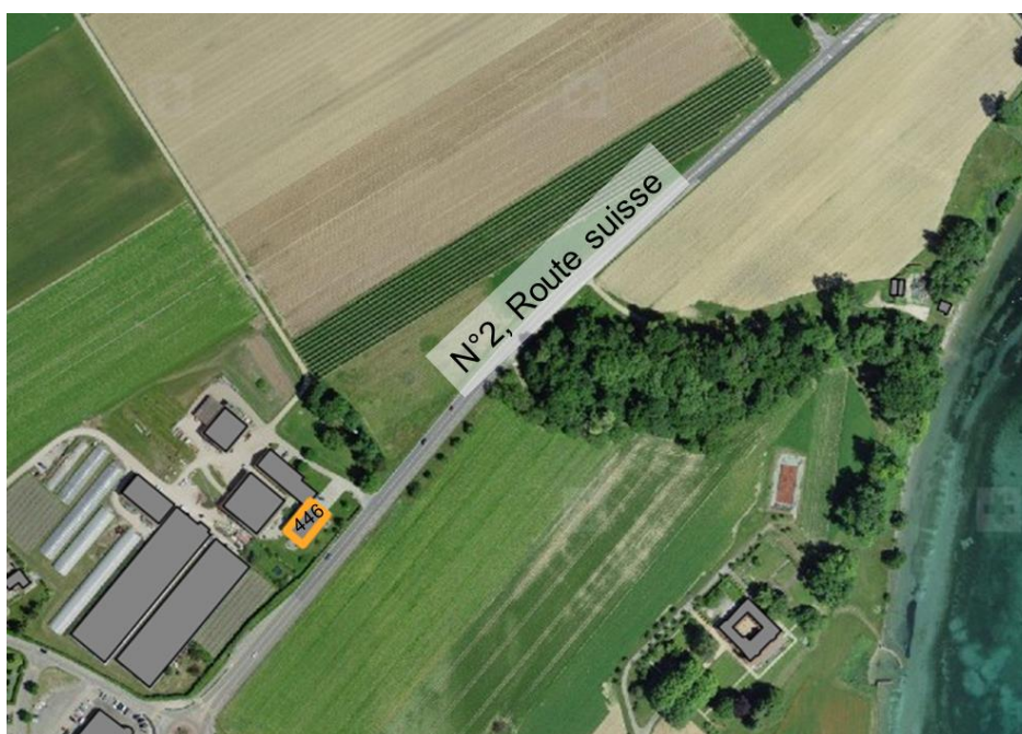
Figure 5.1 Bâtiments sensibles évalués le long de la Route Suisse (tronçon n°2)
