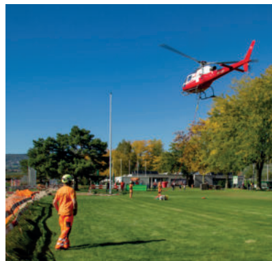
Centre sportif « En Bord » - pose des mâts
