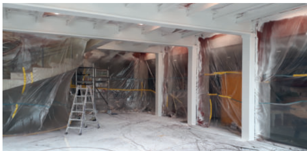
Extension de la galerie du restaurant scolaire
