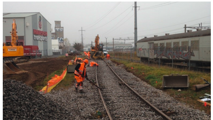
La voie de raccordement
