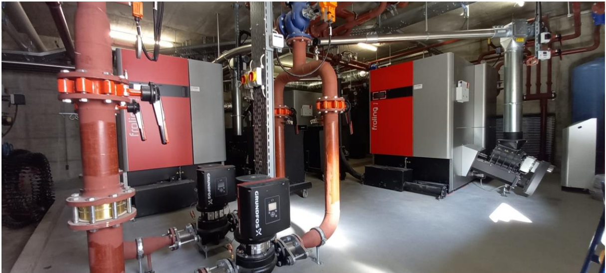
Centrale de Grand Champ après travaux (Photo RES : L. Kausche)
