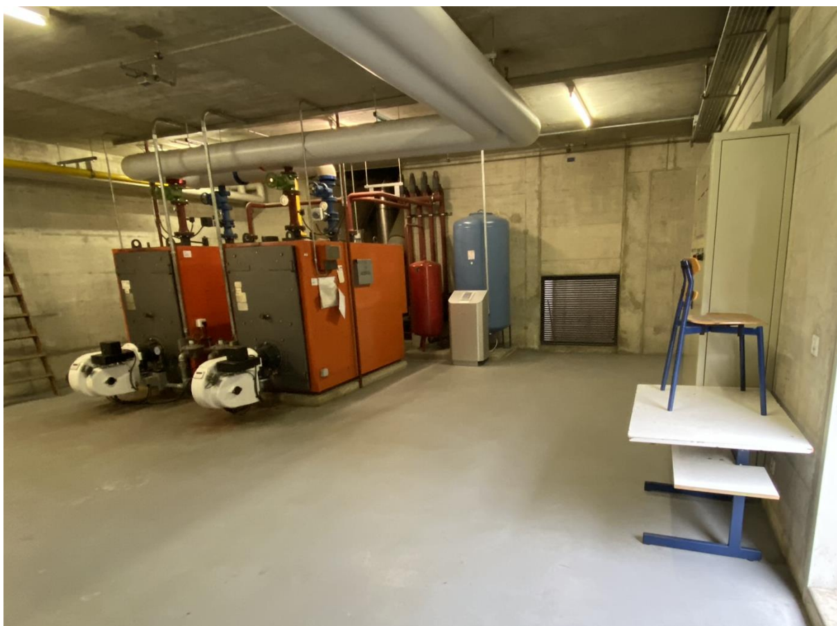
Centrale de Grand Champ avant travaux (Photo RES : L. Kausche)
