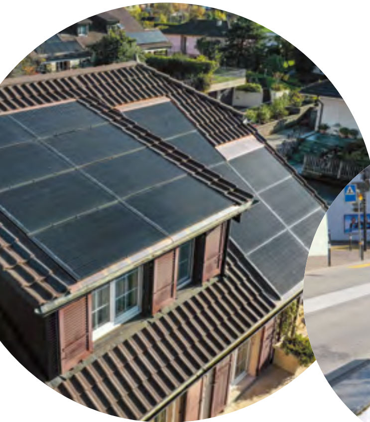
Installation photovoltaïque à Prangins
