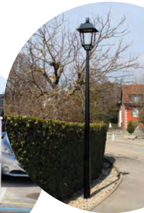
Luminaire LED télégérés à Vich
