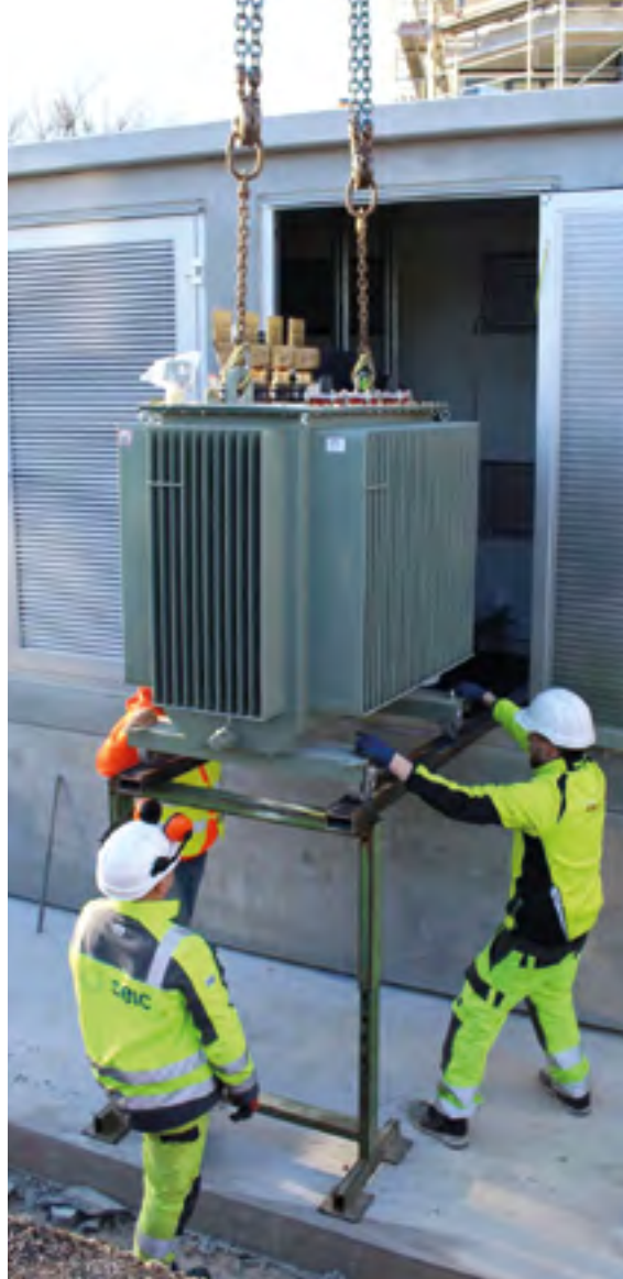
Pose d'un transformateur aux «Lisières» à Gland
