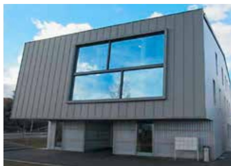
Le nouveau bâtiment de Montoly a été réalisé aux normes Minergie.
