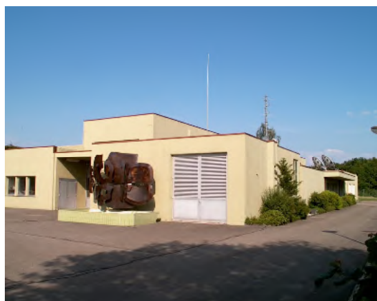
Station de filtration de l’Asse
