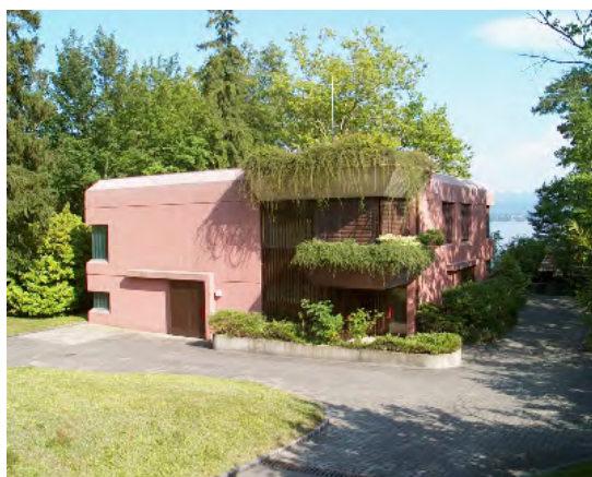
Station de pompage de Promenthoux
