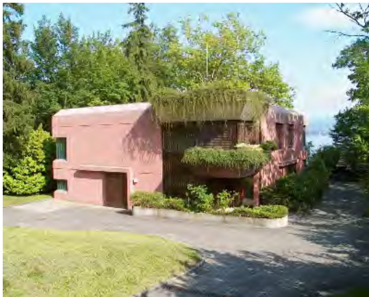
Station de pompage de Promenthoux
