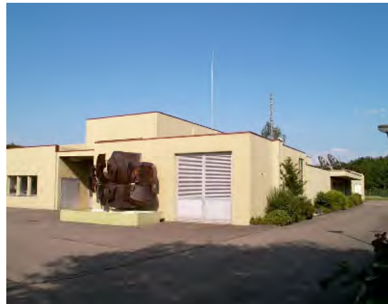
Station de filtration de l'Asse
