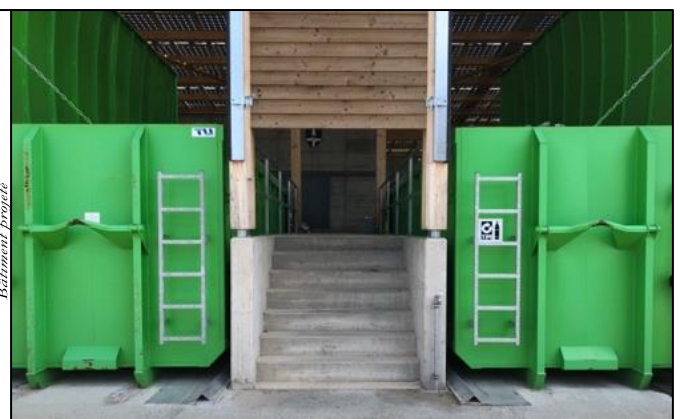
Figure 4: accès aux bennes depuis le stationnement des déchets verts
