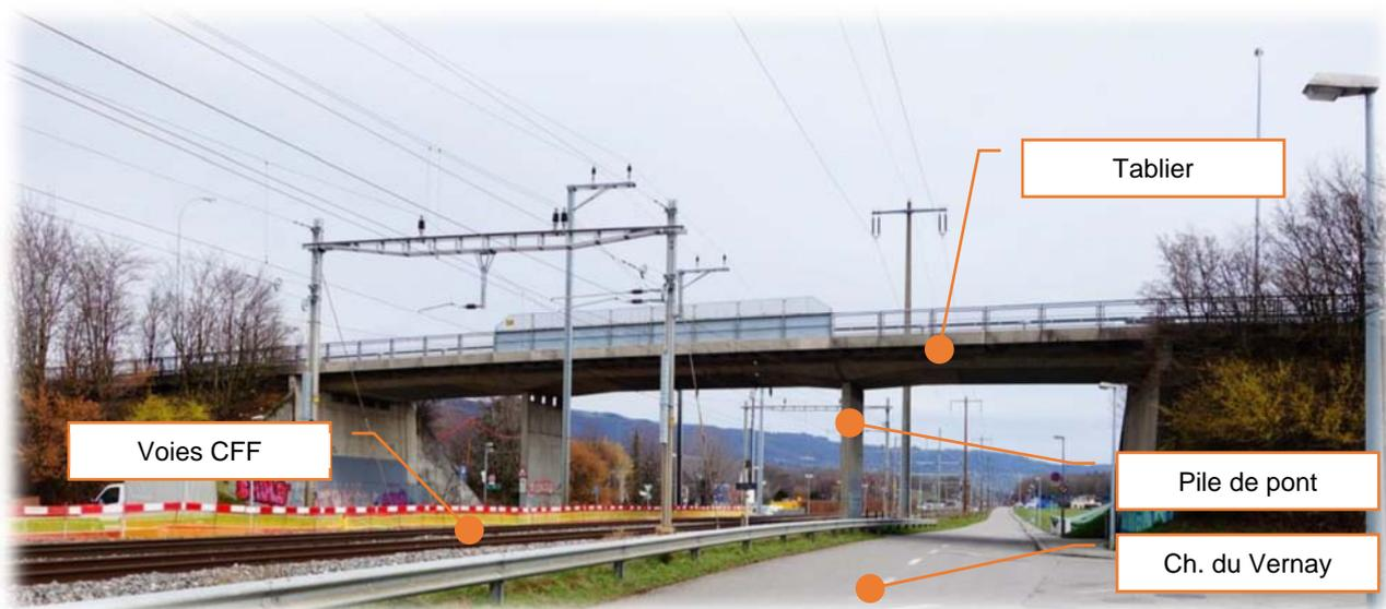
Figure 1 : élévation du pont de la Vy-Creuse
