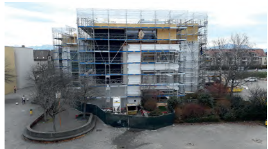
Bloc E - Surélévation
