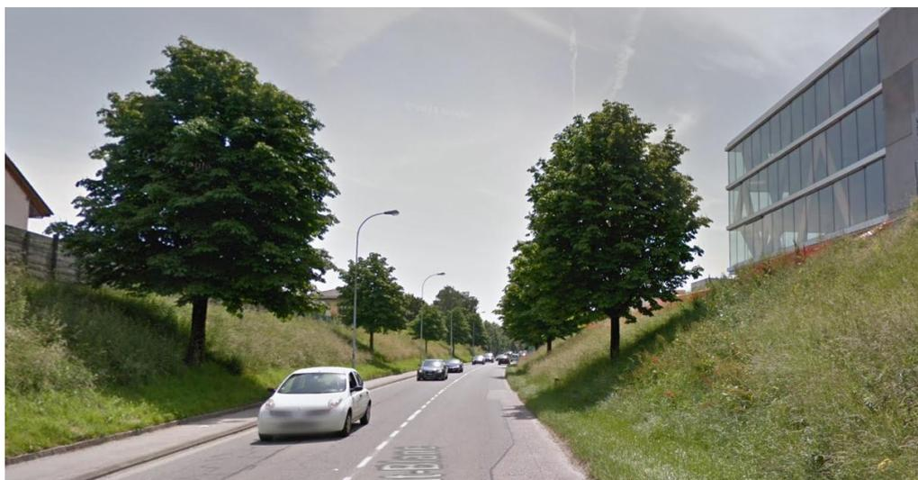
Sur l'extrait de la situation ci-dessous, nous observons les 6 paires d'arbre avec un entraxe de 30 [m]. Longitudinalement la route possède une pente de 0.5 % en direction du Lac. La longueur du tronçon entre le PI CFF et le giratoire Rue du Midi / Route des Avouillons est d'environ 220 [m].
