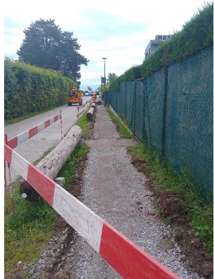
Chemin de la falaise – finition chemin terre-pierre
