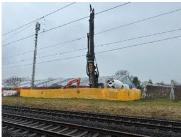
En-Bord : Forage pieux cellule de départ
