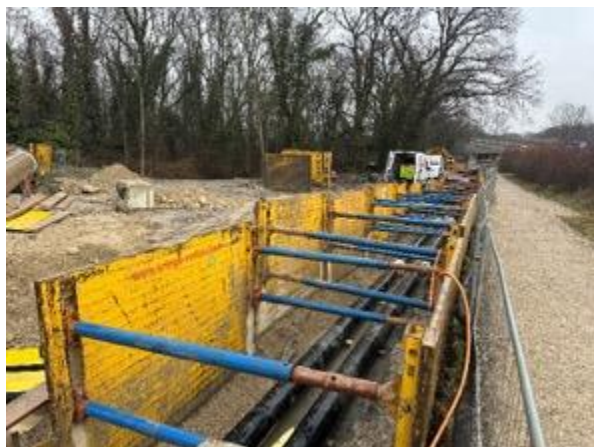
Chemin du Stand : pose des conduites CAD
