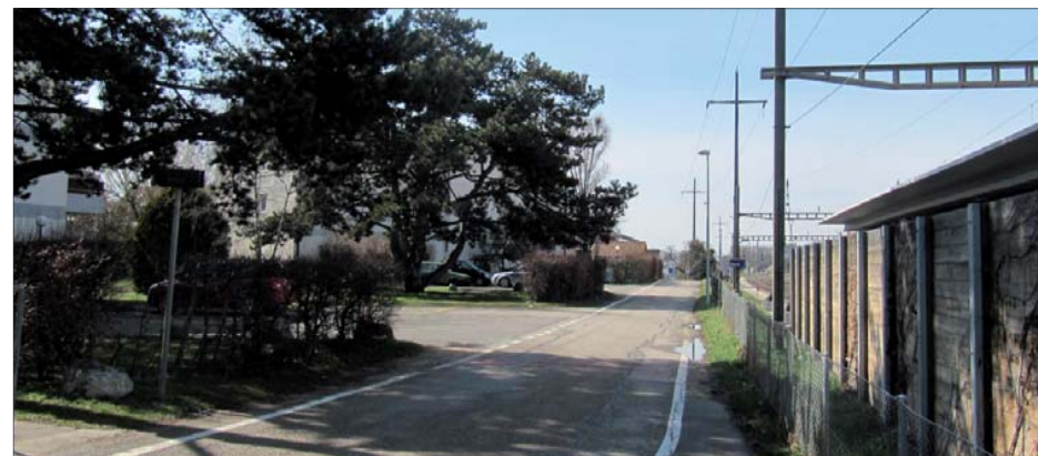
Chemin de la Crétaux : une future paroi antibruit à intégrer
