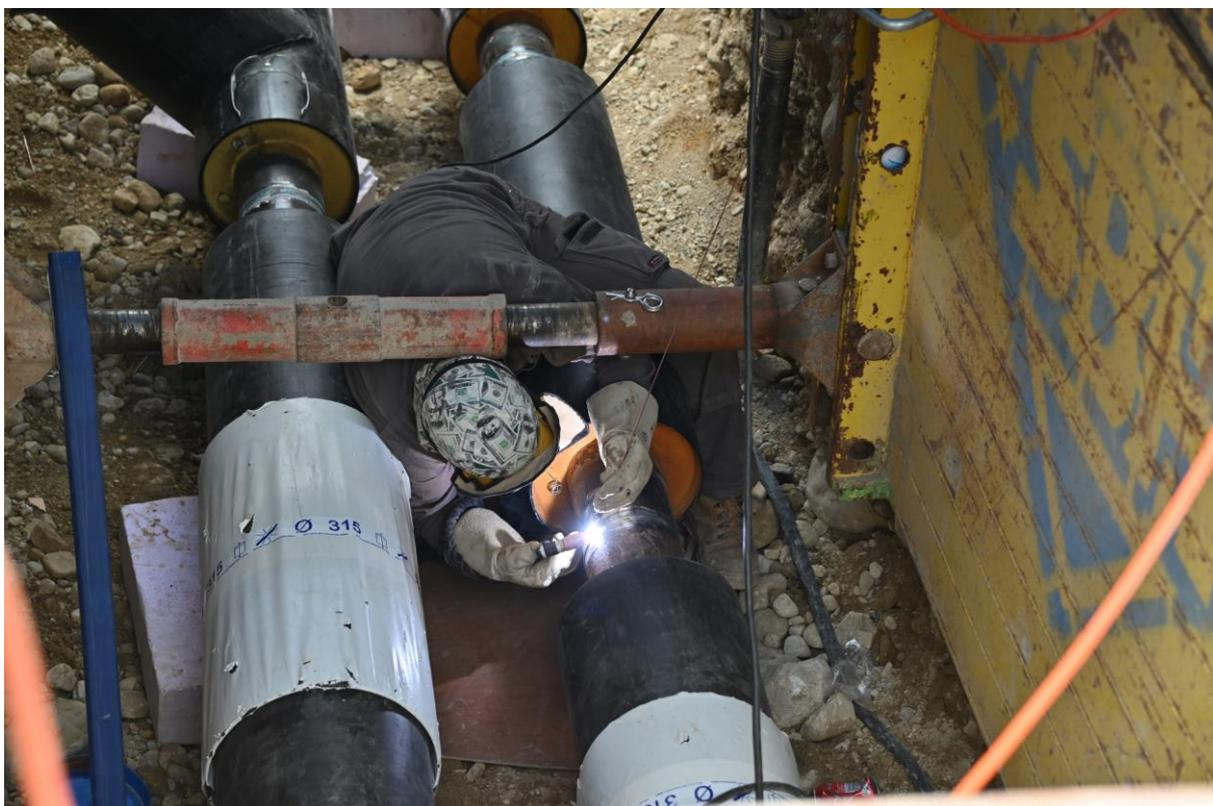
Raccordement des CAD Eikenøtt et CTG : soudage des conduites
