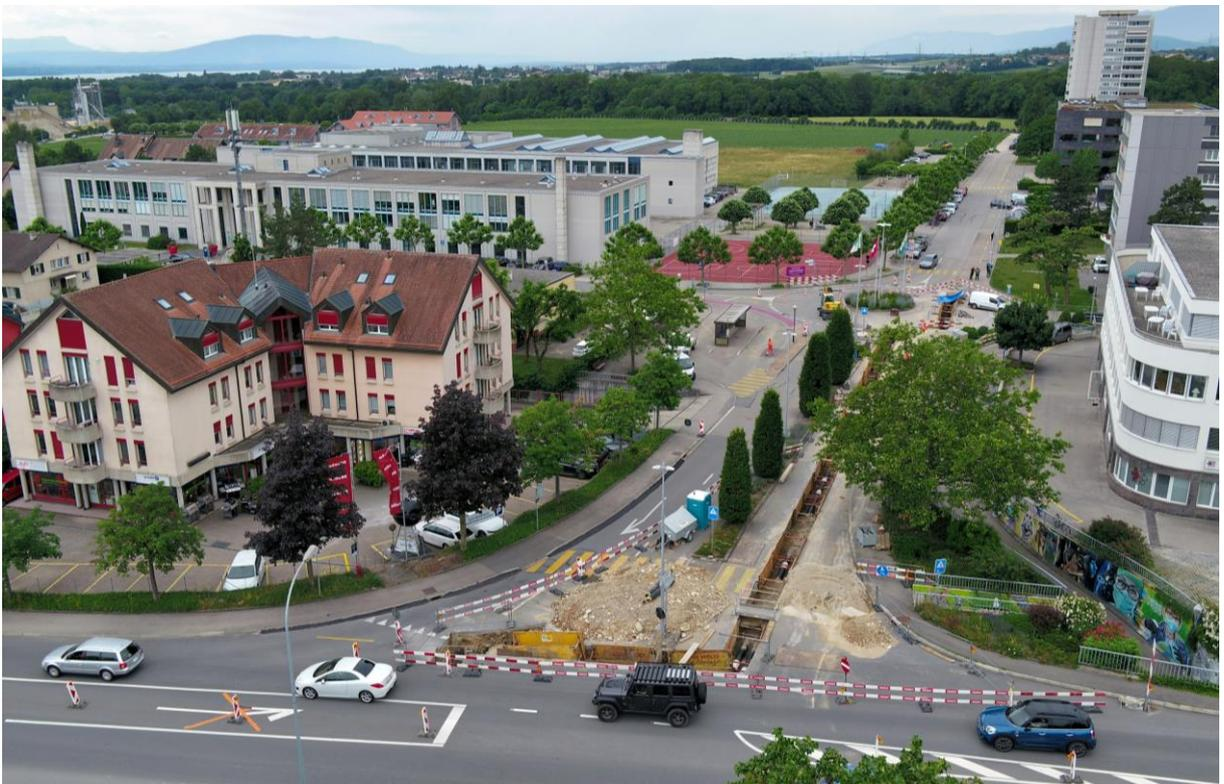
*Raccordement des CAD Eikenøtt et CTG : fouille et pose des conduites à la rue des Tuillères
