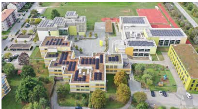
Centrale solaire, Perrerets
