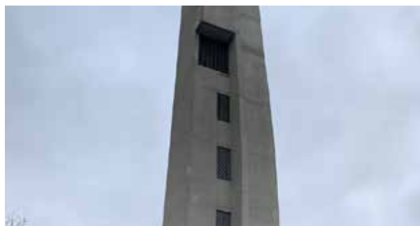
Campanile après travaux
