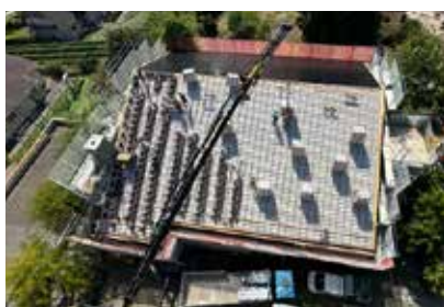
Toiture Temple, travaux en cours
