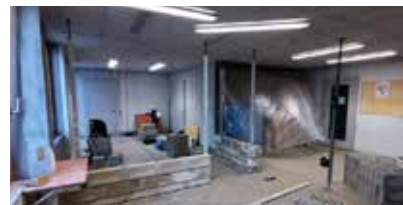
Montoly bureau rez, travaux en cours
