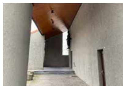
Couvert Temple après travaux
