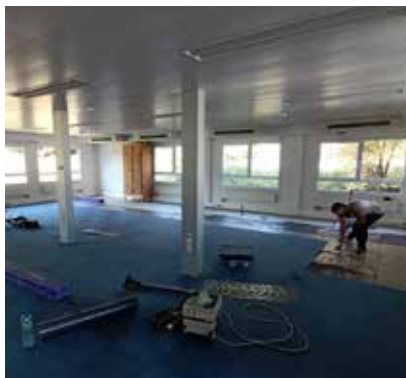
MB 29 rez travaux en cours
